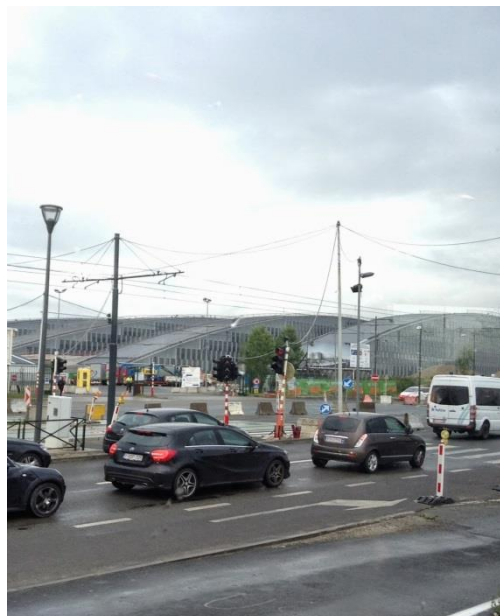
Nueva sede de la OTAN en construcción (Foto: PND).
